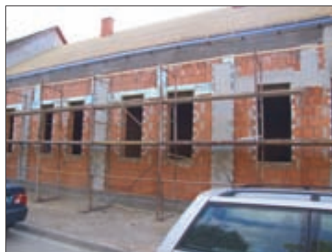
Az épülő parókia
